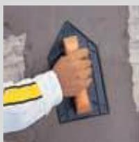
Una vez el producto haya perdido gran parte de agua (transcurridas 5-6 horas aproximadamente según espesor y condiciones de secado), y haya empezado a coger consistencia, fratasar la superficie con un fratás.
