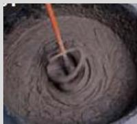
Amasar **weberev hidro** con 4 – 5 litros de agua limpia por saco, mediante batidor eléctrico o máquina de proyectar, hasta su total homogeneización.
