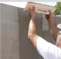
Extender el producto manual o mecánicamente dejando un espesor máximo de 10 mm por capa hasta un máximo de aplicación de 20 mm, y reglearlo para regular el espesor y alisar la superficie. Si se trabaja en dos capas, aplicar fresco sobre fresco o dejar de 6 a 12 horas en la aplicación entre capas.
