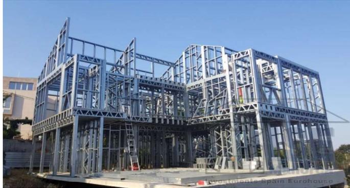
*Estructura de acero galvanizado tratado en zinc, resistente a cambios de temperatura drásticos, anti salitre, resistente al paso del tiempo.*
